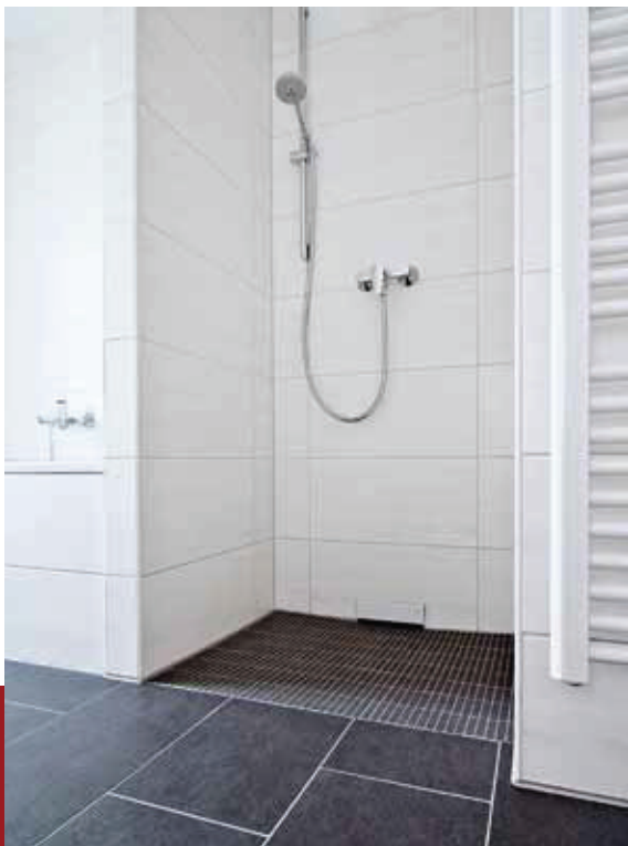
Ein bodengleicher Duschbereich ist auch in kleinen Bädern realisierbar, wie dieses Bild zeigt. (Foto: Geberit)
